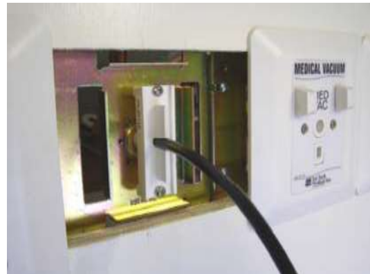
Kit unido a la parte oculta de la salida de gases medicinales
